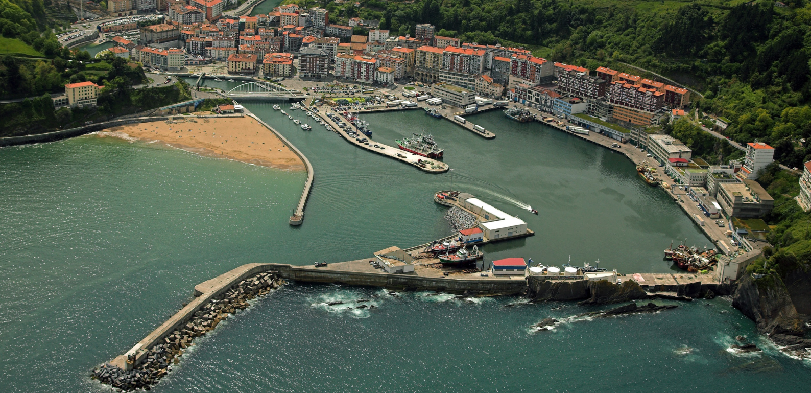
Analyse de l'état actuel et du projet de renforcement de la digue du port d'Ondarroa
